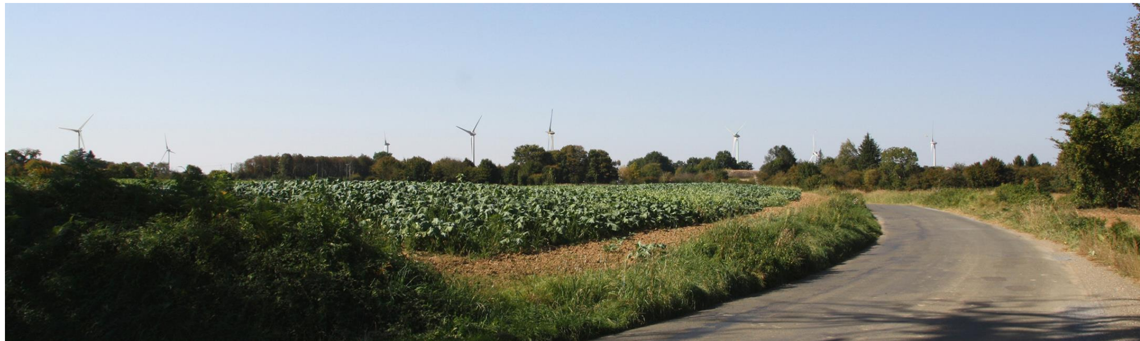
Photomontage avec des éoliennes culminant à 150 m en bout de pales (et avec une tour de 109 mètres)
