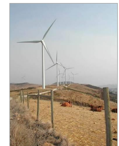
Parc éolien de Torres Vedras (Portugal)
